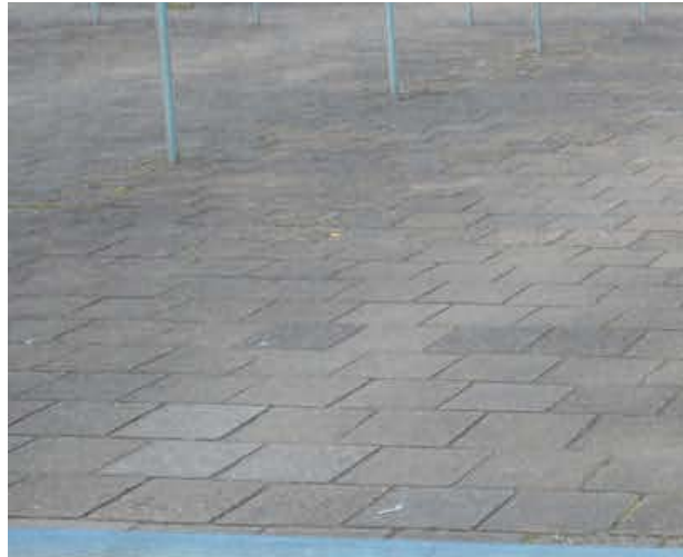
30x30 betontegels. Referentie bestaande fietsenstalling Olympus College
