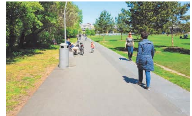
Circuit Park Am Gleisdreieck, Berlijn. Basisprofiel 4 m, gebruik: twee richtingen door fietsers, joggers, wandelaars, skaters
