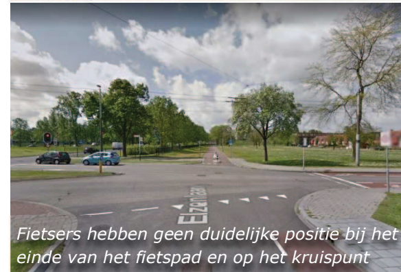
Onvoldoende continuïteit van de fietsroute
